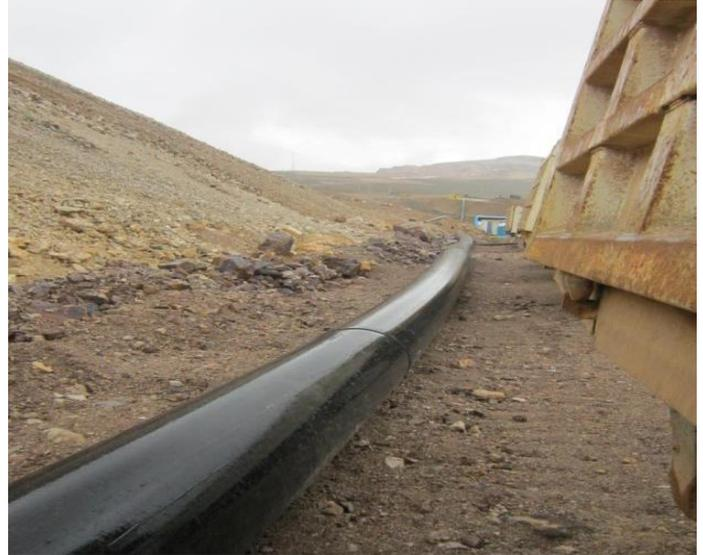
**OBRA:** "POZA DE AGUA TRATADA AWTP ESTE-INSTALACION DE TUBERIAS DE 24"φ DE ACERO AL CARBONO Y HDPE"
