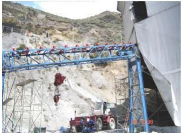
**OBRA:** FABRICACION Y MONTAJE DE FAJA TRANSPORTADORA DE 36”.
