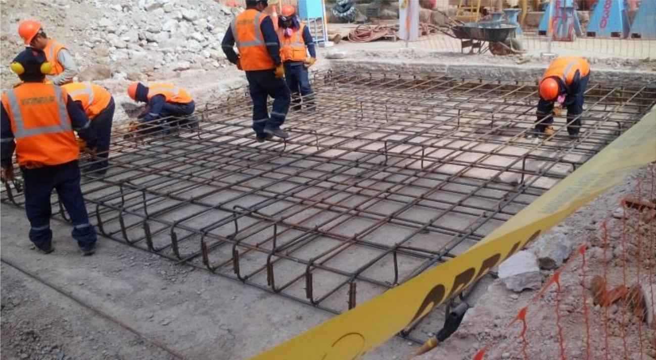
**OBRA:** “REPARACIÓN DE LOSA DE CONCRETO ARMADO DE 4.5M X 13M Y REUBICACIÓN DE COMPRESOR EN TALLER”
